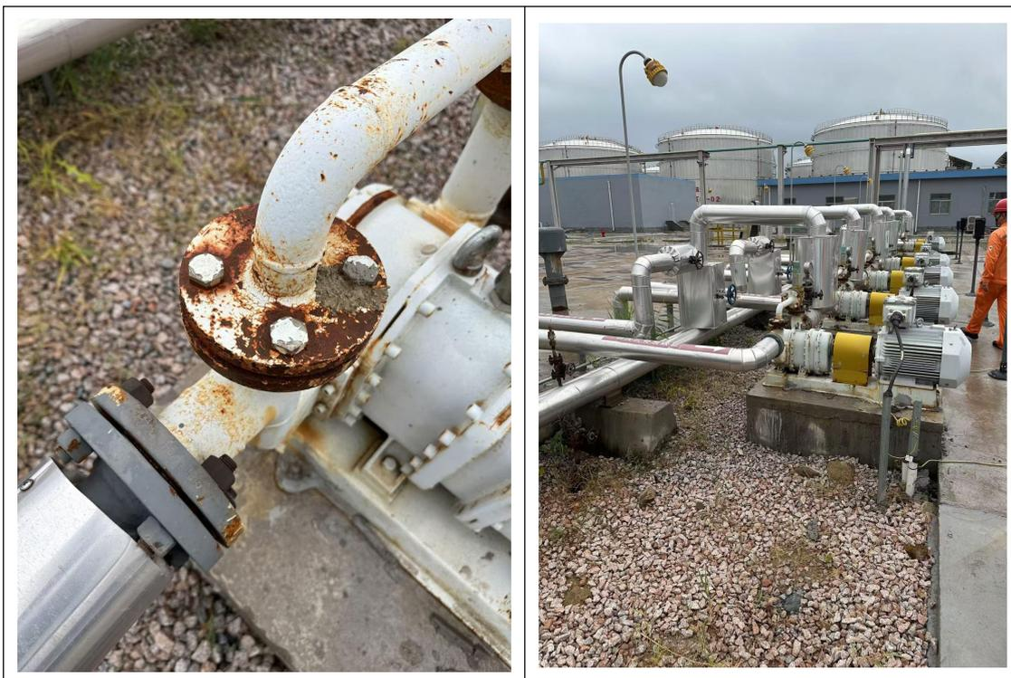
经排查，生产管线均为地上架空管线，无异常渗漏点，泵体无异常情况，企业于 2024 年 8 月委托青岛安洁环境工程有限公司对全厂涉及挥发性有机物 VOCs 的装置开展泄漏检测与修复项目（LDAR）。江苏润海油品销售有限公司本轮次 LDAR 涉及 VOCs 密封点共 633 个，首次检测所有检测点位中大于或等于泄漏阈值的点共计 0 个。LADR 检测报告详见附件 12。
