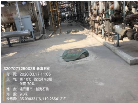
污水或污油地下输送管线
