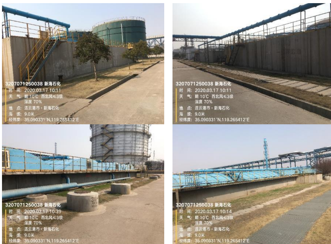
污水处理站现场踏勘照片
