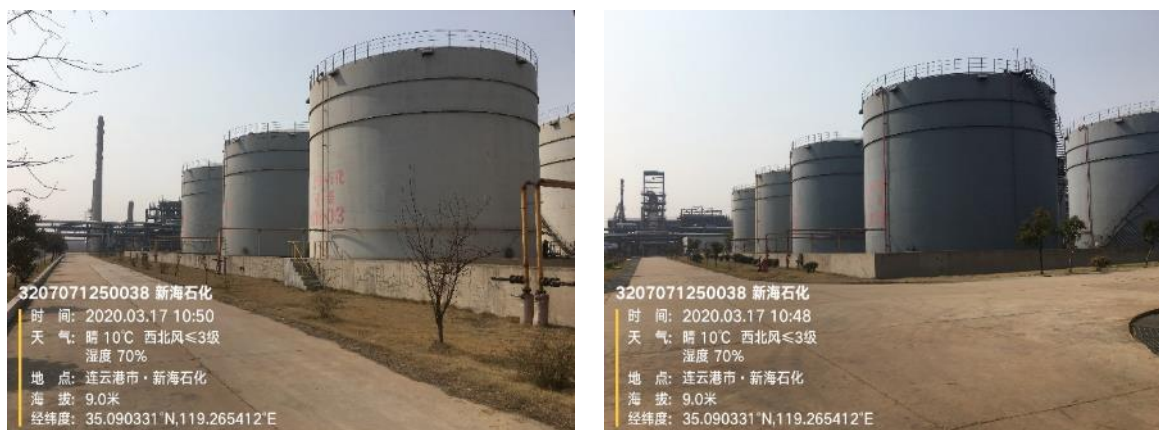
图 4.3-3 部分罐区现场踏勘照片
